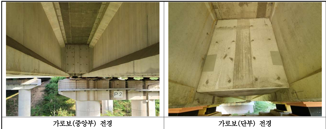
【사진 13.3.6】 가로보 전경
