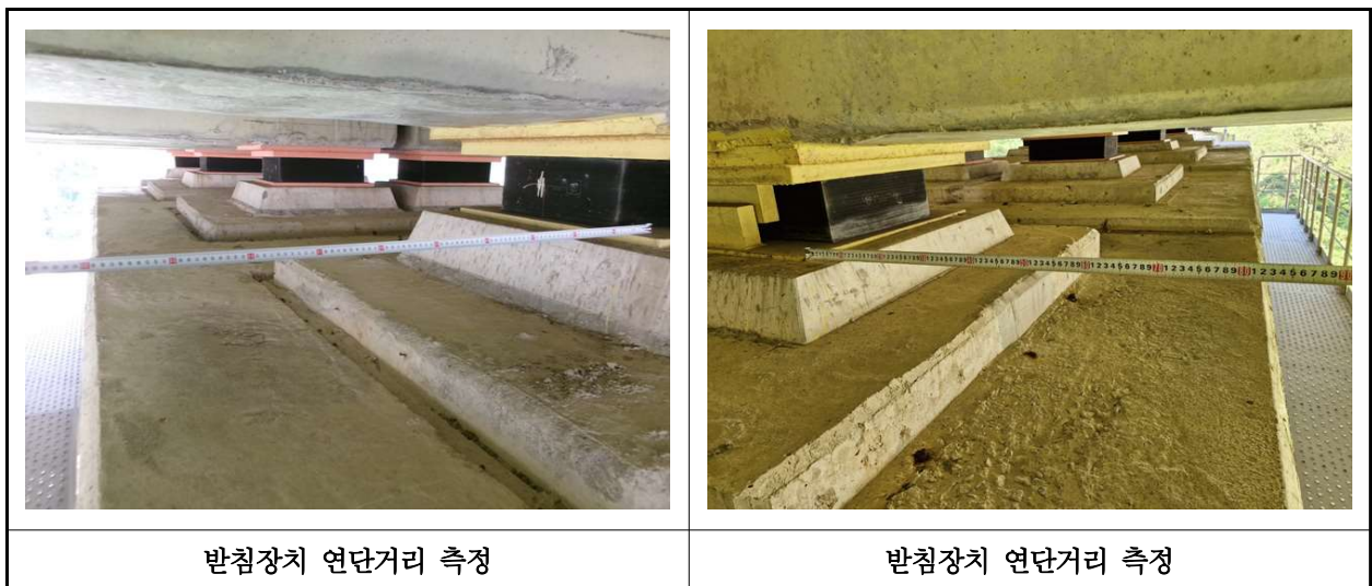
【사진 13.3.15】 교량받침장치 연단거리측정
