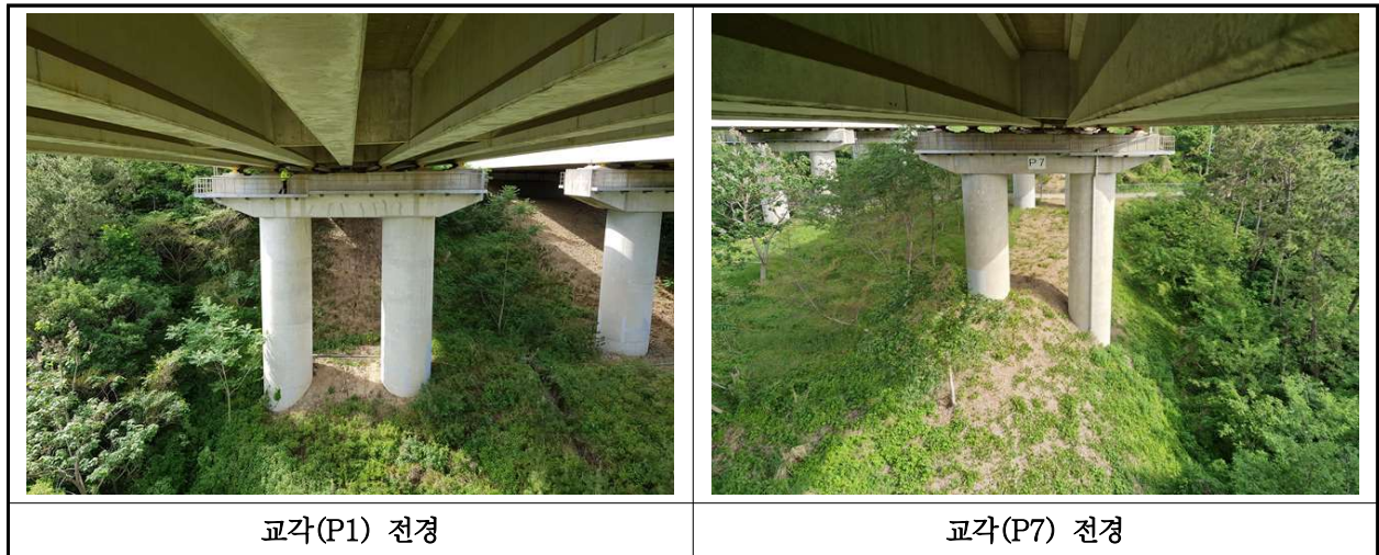
【사진 13.3.10】 교각 전경
