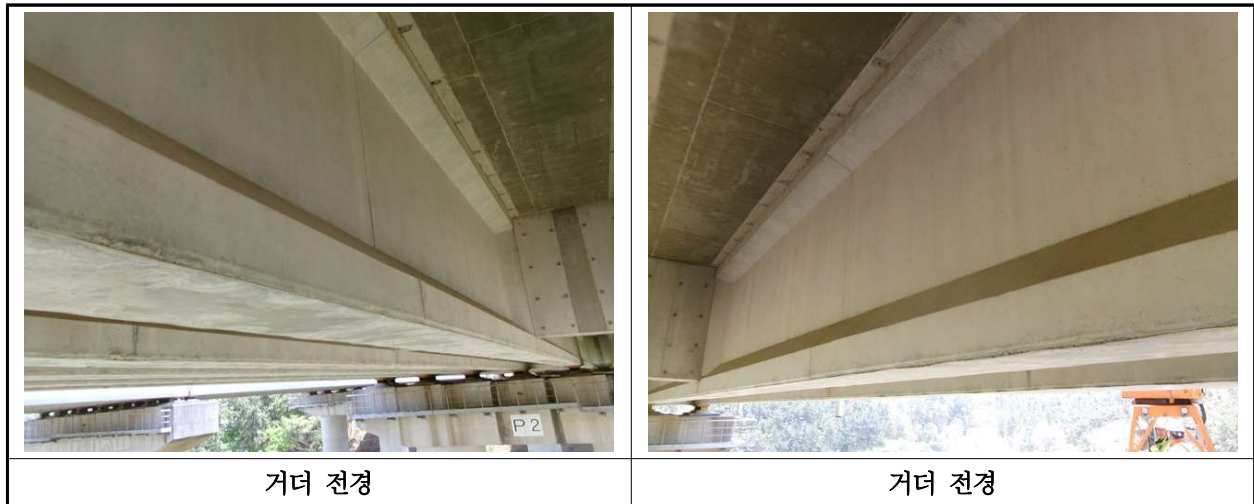
【사진 13.3.4】 거더 전경
