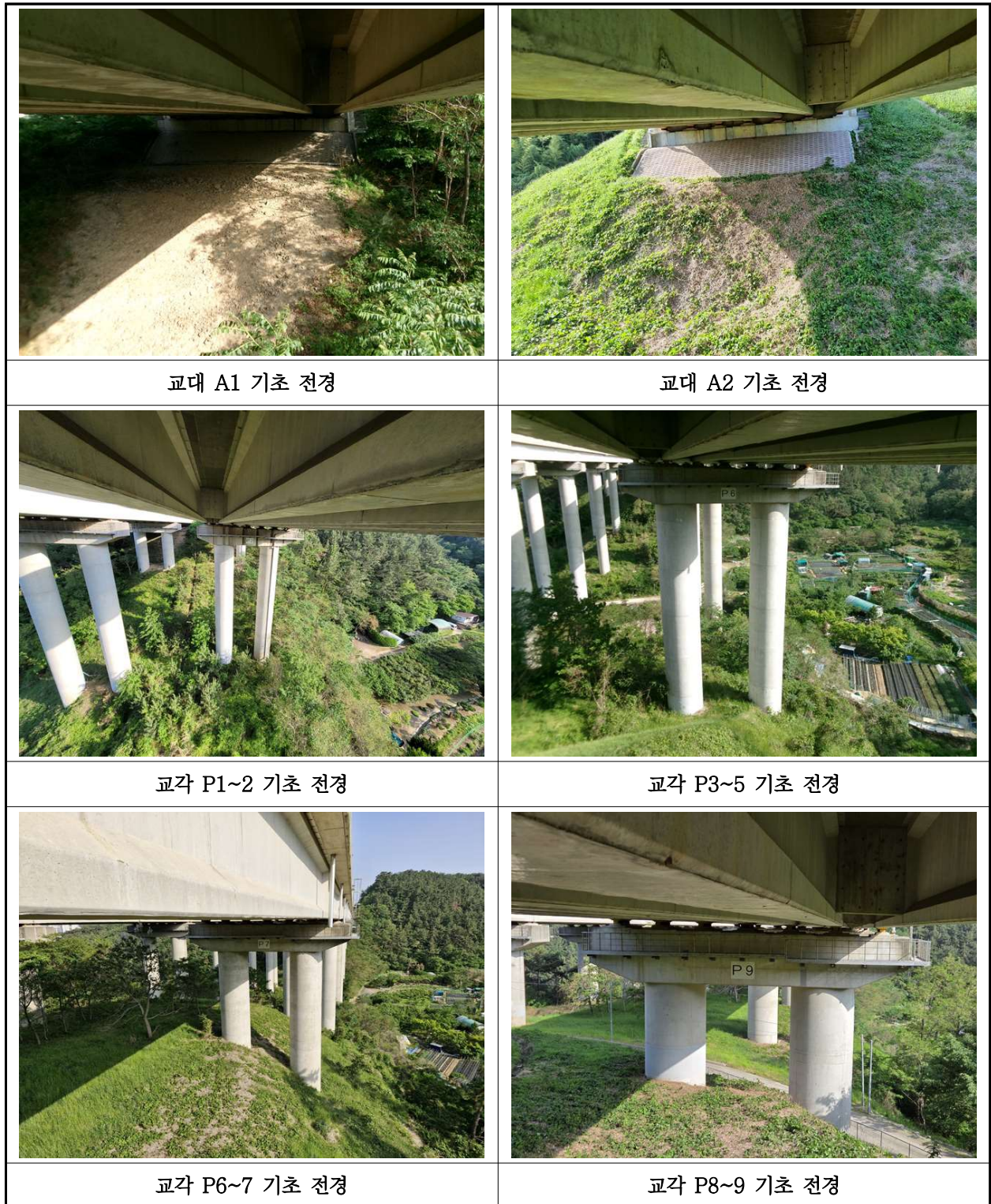
【사진 13.3.12】 기초 전경
