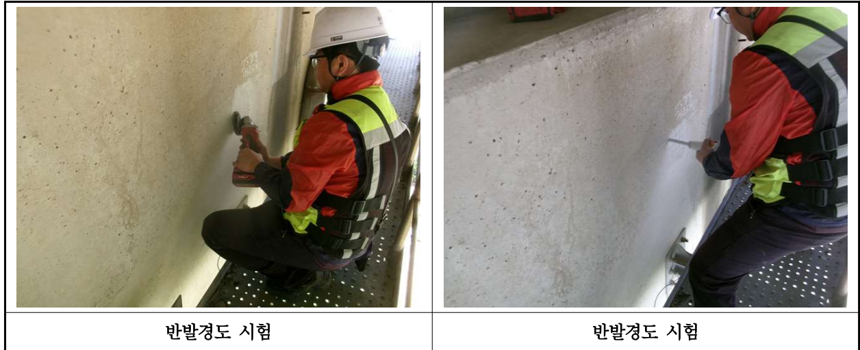
【사진 13.4.2】 반발경도시험 현장사진
