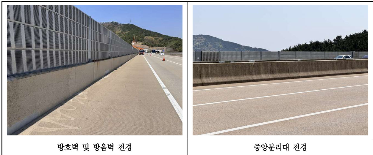
【사진 13.3.24】 방호벽 및 중분대 전경
